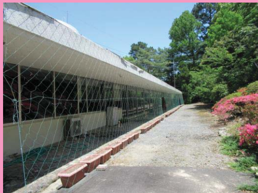
《 ネット張り完了 》
